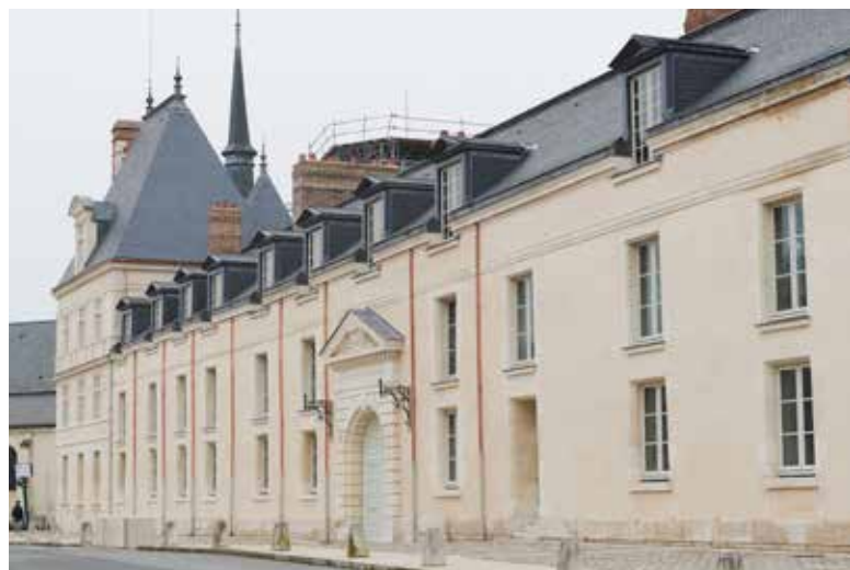
Façade sur rue, avant et après restauration © Benjamin Gavaudo - CMN
