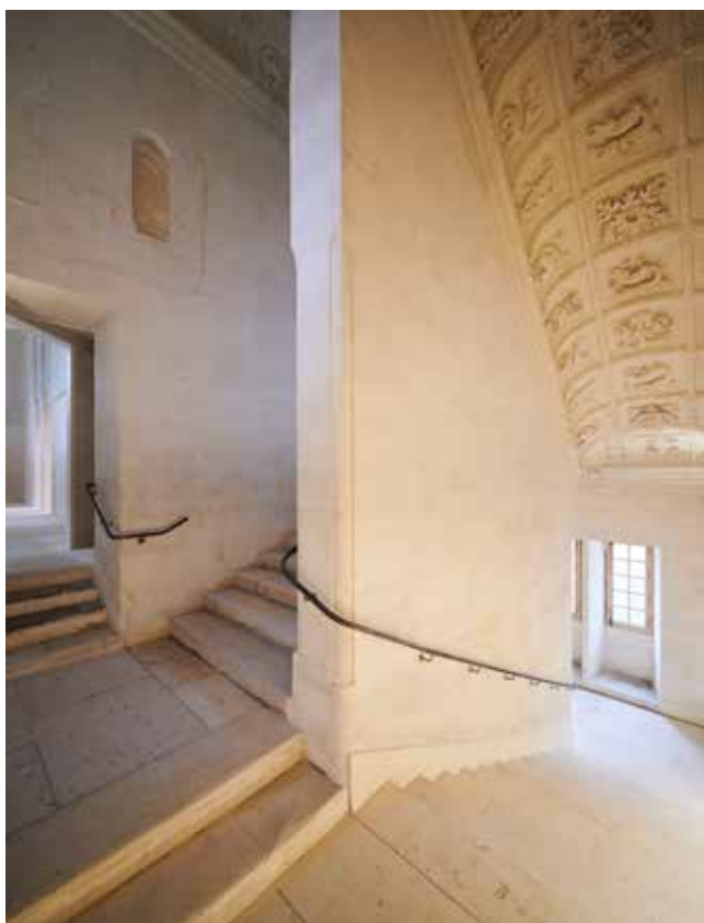
Escalier du Roi restauré © Benjamin Gavaudo - CMN
